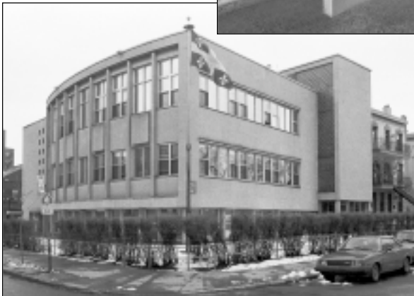
4499, avenue de l'Esplanade Photos : Pierre Perrault, BNQ
